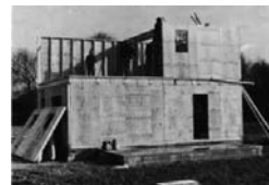
Ci-dessus : Illustrations 34a et 34b La Borne de l'Espoir, chantier (© Jean-Pierre Watel).
